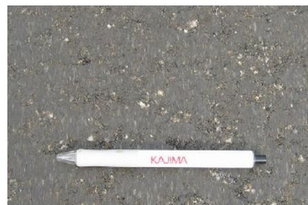
写真-11 車道用土系舗装表面
