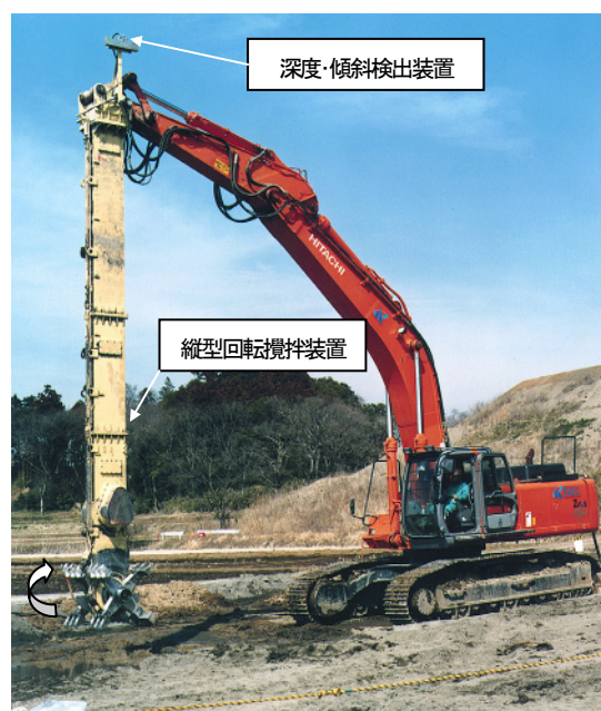
写真－1 縦型回転攪拌混合（TB）工法施工機
