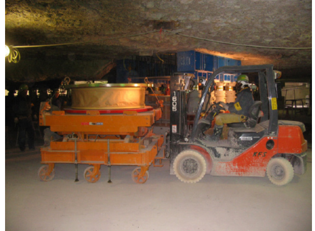
写真-5 免震装置運搬
