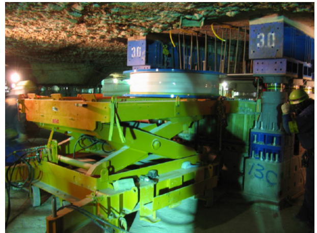
写真-6 免震装置据付
