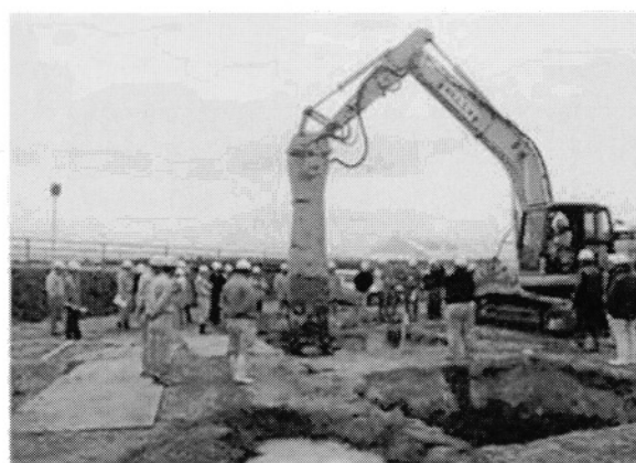
図 3.4. 施工実験状況
