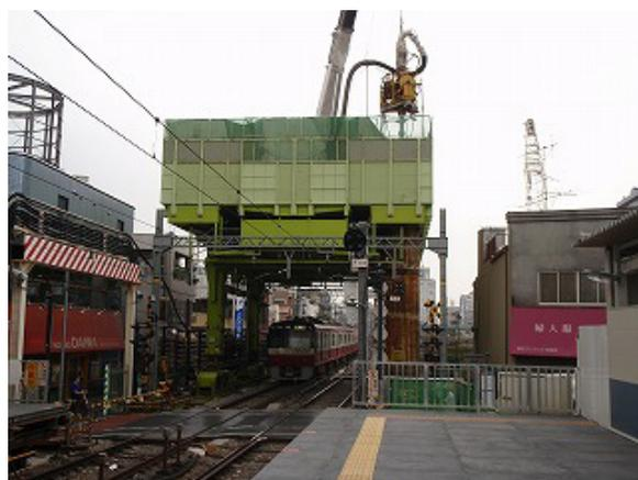
写真-6 基礎杭施工状況
