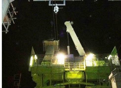
写真-11 PCa 柱建起し状況
