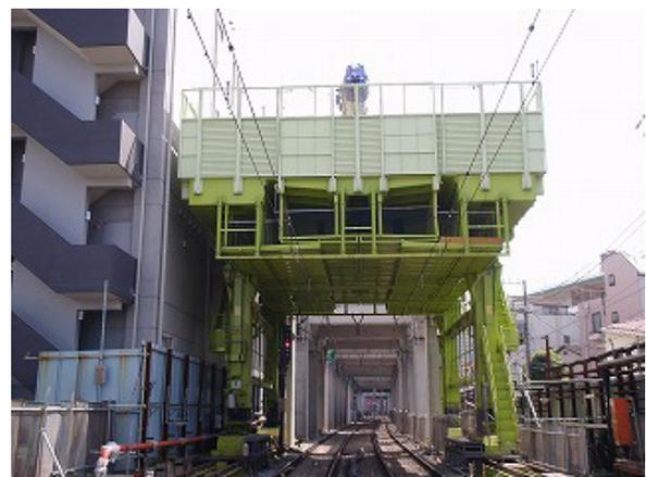
写真-2 柱梁架設施工機導入状況
