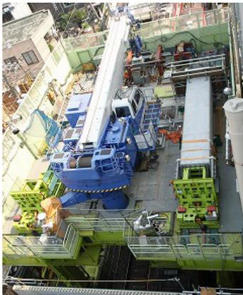
写真-5 PCa 柱建起し装置
