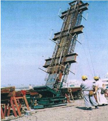
写真-4 鉄骨建起し装置
