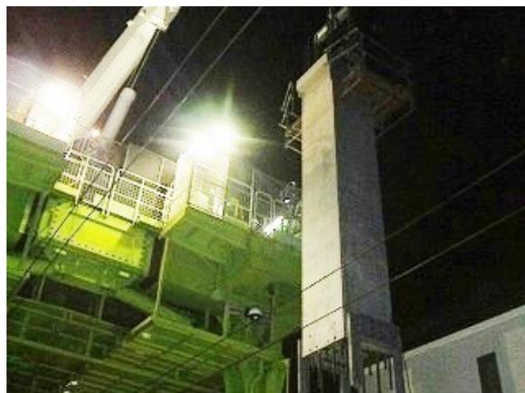
写真-7 PCa 柱架設状況
