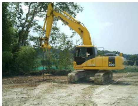
写真2 貫入作業の状況
