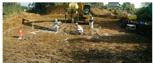
写真7 試験貫入施工
