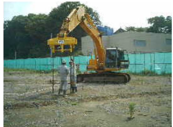
写真 9 実績宅地での補修改良状況
