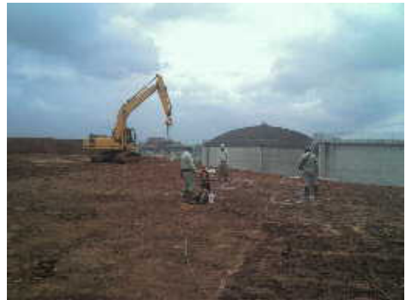
写真 8 実績現場での改良状況
