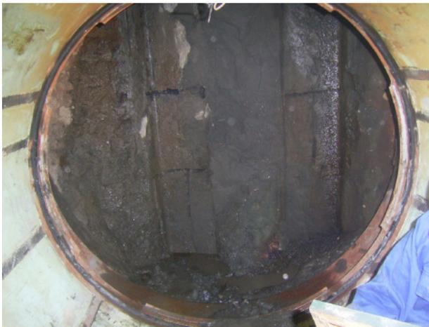
写真 - 5 鋼矢板撤去完了状況
