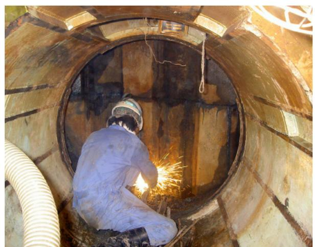
写真-4 鋼矢板切断状況
