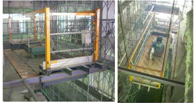
写真・5 搬器各階停止状況と昇降状況
