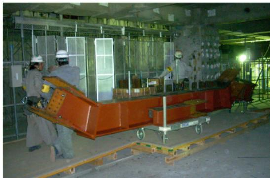
写真・1 耐震鋼製枠資材
