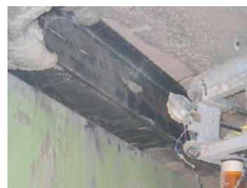
写真1 除去後のH鋼梁面
