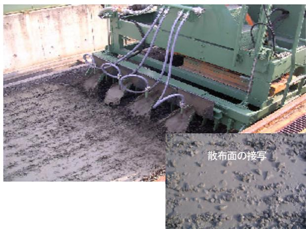
写真-2 スラリー散布状況と散布面
