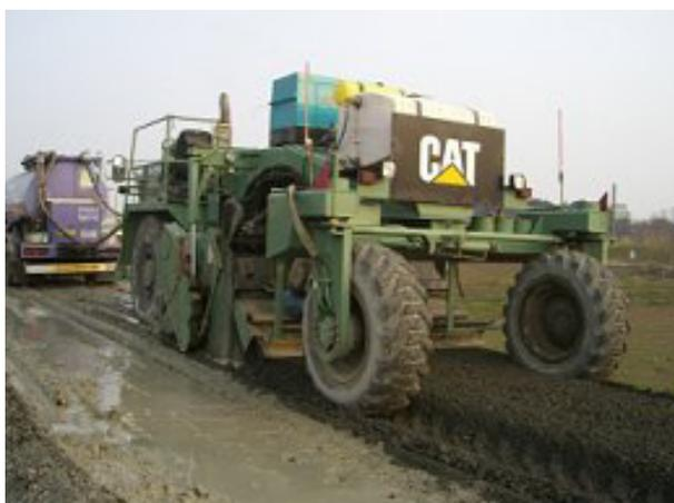
写真-4 破碎・混合状況
