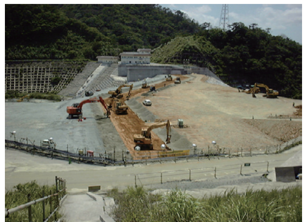
写真-2 盛立の施工状況
