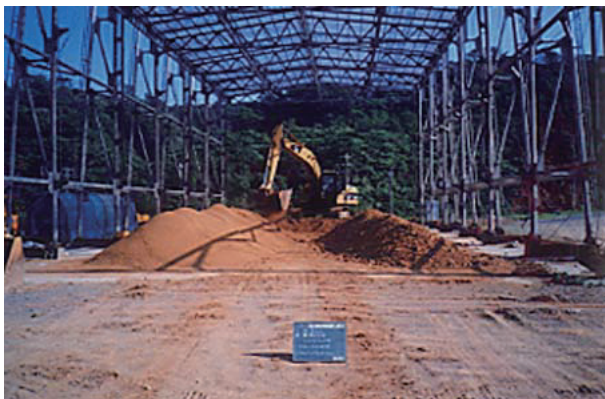
写真-3 昇降屋根付き曝気設備
