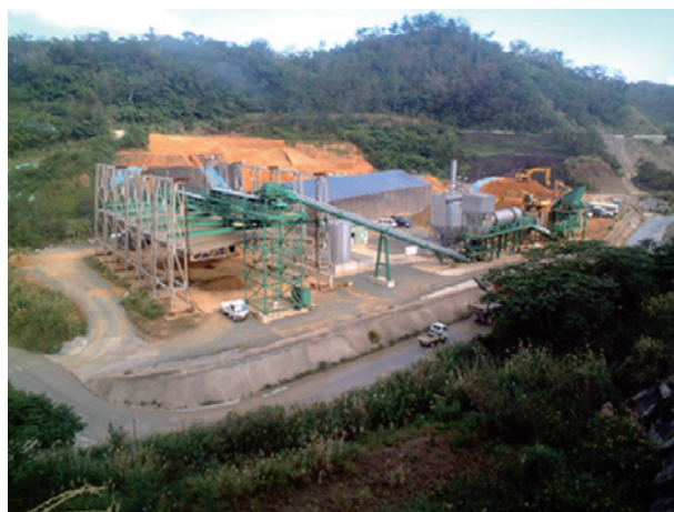
写真-6 強制曝気設備（全景）
