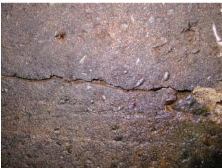
写真-1 点検で確認された構造ひび割れ
