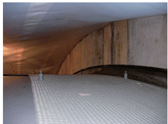
写真-8 ラップ部の敷設状況
