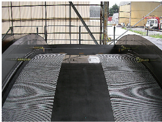
写真-3 繊維シート敷設状況
