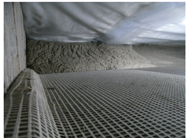
写真-12 打設状況
