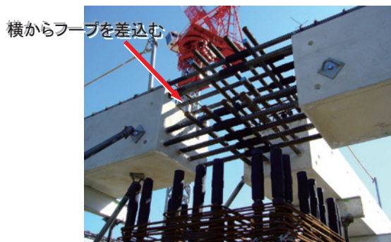
写真-1 T型配置の梁 PCa
