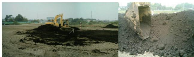
写真-5 改良腐食土の盛土工区での撒きだし転圧状況
