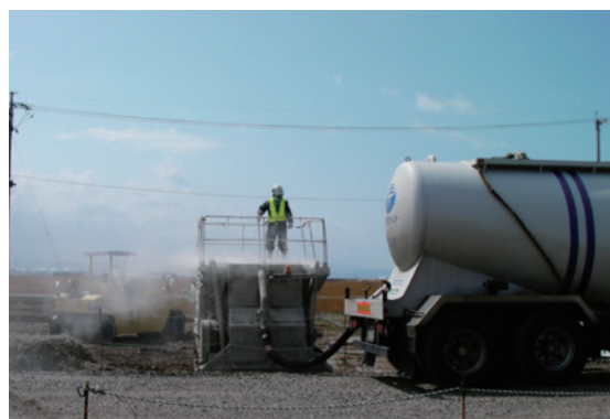
写真-1 ローリから供給時の発塵状況
