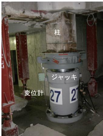
写真-3 油圧ジャッキ設置状況
