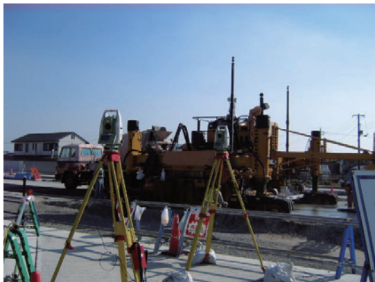
写真-2 施工状況
