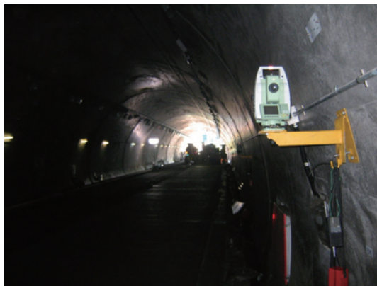
写真-4 TS 設置状況
