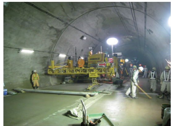
写真-5 施工状況
