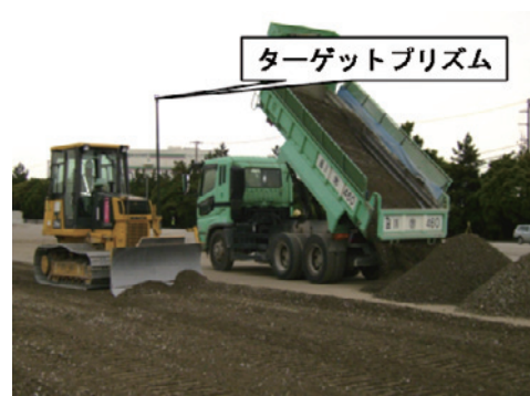
写真-2 3D-MC 付ブルドーザでの敷きならし状況
