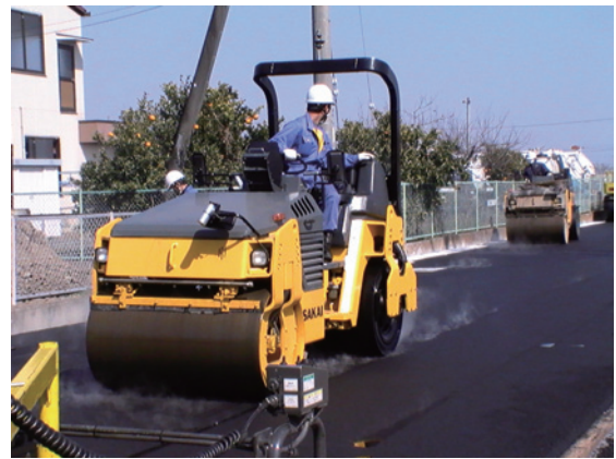
写真-4 初期転圧状況
