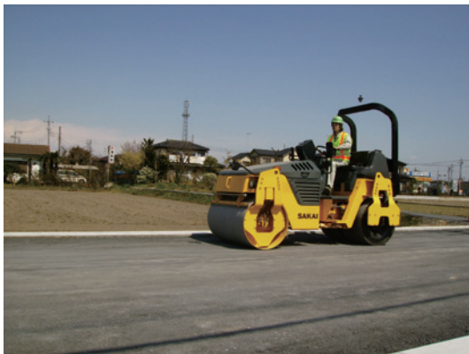
写真-3 CISによるCCV測定状況
