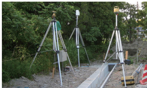
写真-1 GNSS 式基地局設置状況
