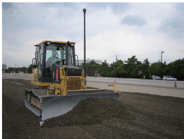
写真-4 TS 式ブルドーザ路盤施工状況
