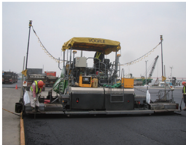
写真-5 GNSS 式基層施工状況
