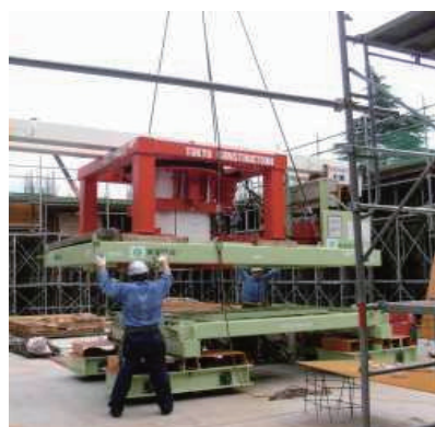
写真-6 組立状況（上部取付装置搭載）
