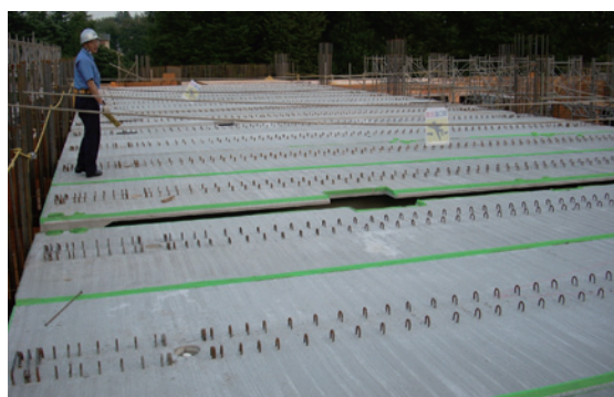
写真-11 施工完了部
