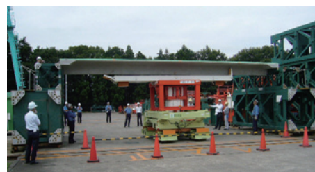
写真-3 操作確認試験
