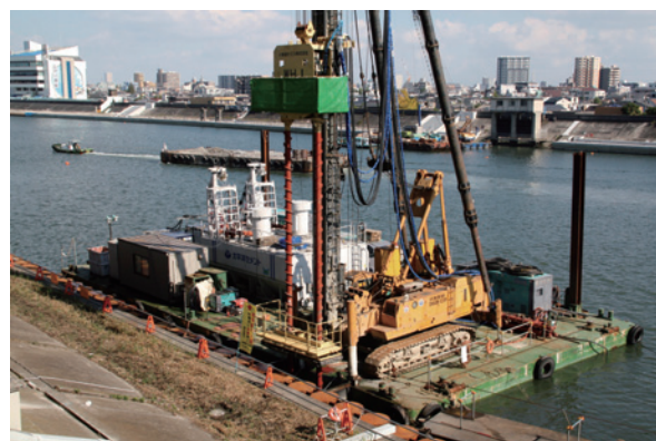
写真－2 台船上に搭載した WHJ 施工機械全景
