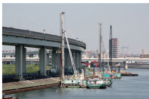
写真－３ 中堤地区 WHJ 施工状況
