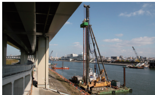
写真－1 WHJ工法と護岸施工状況
