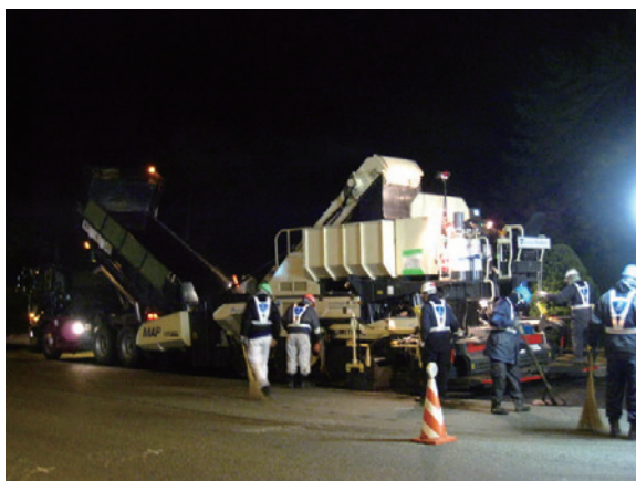
写真-7 表層施工状況
