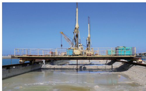
写真－2 NJP 施工機本体全景
