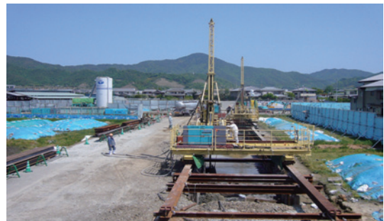
写真-4 開削部の NJP 施工状況
