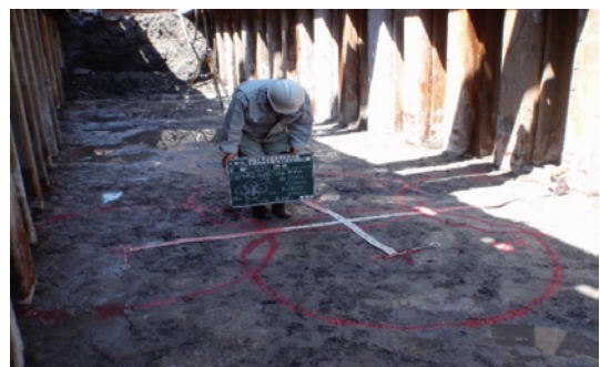
写真-5 水路部開削によるNJP改良確認状況
