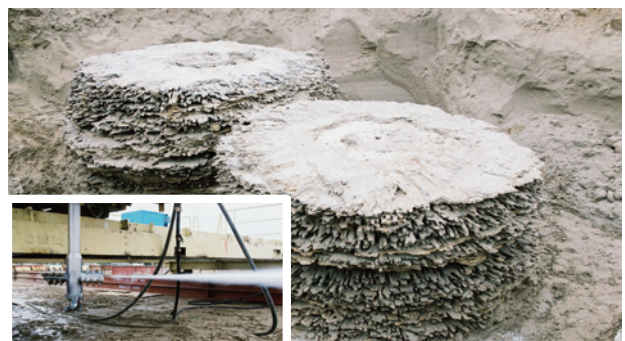
写真－1 NJP 攪拌翼と造成改良体
