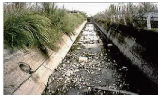
写真-3 現状の用排兼用の開水路 1)
