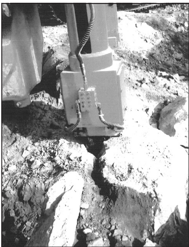
写真-2 割岩状況
