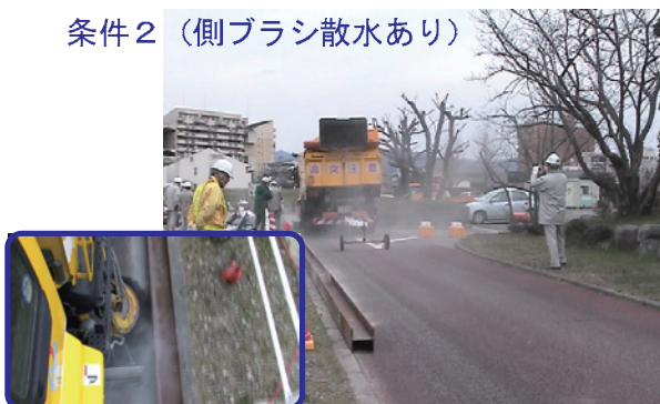
写真-1 調査状況
