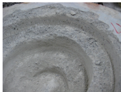
段階的に掘削が出来た様子
