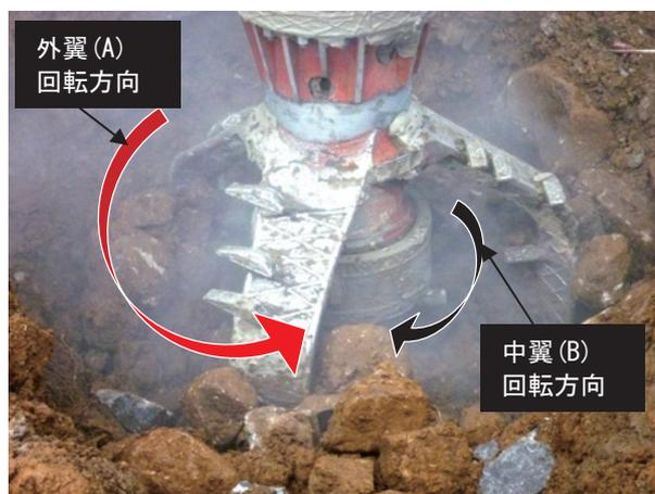
写真-5 転石混在層攪拌状況
