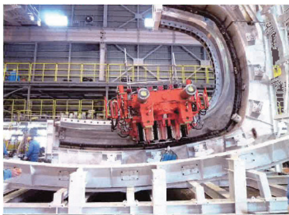
写真-1 実証実験架台
