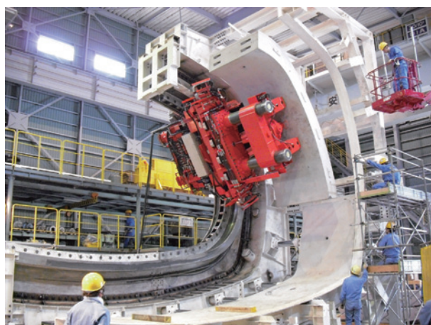
写真-3 セグメント組立状況
