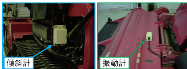
写真-5 傾斜計・振動計
