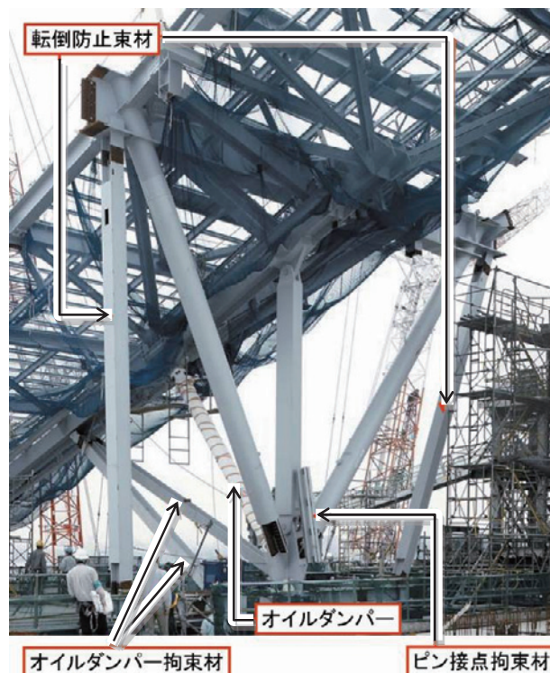
写真-8 トラス支持拘束材詳細
