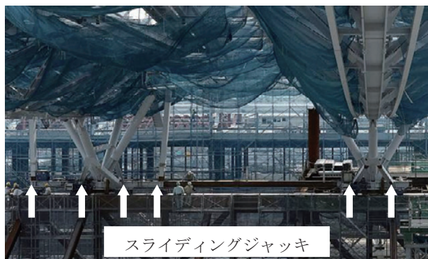
写真-4 トラスの柱脚支持部
