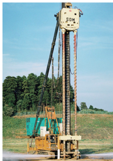
写真-1 SDM-Dy 二軸式施工機の噴射状況
