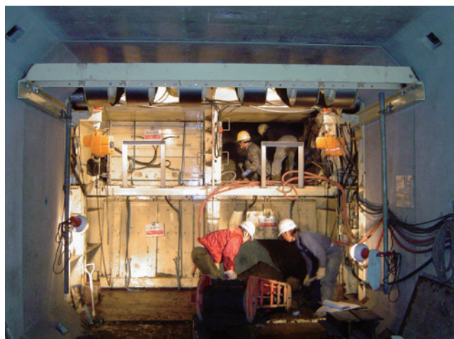
写真-4 掘削状況
