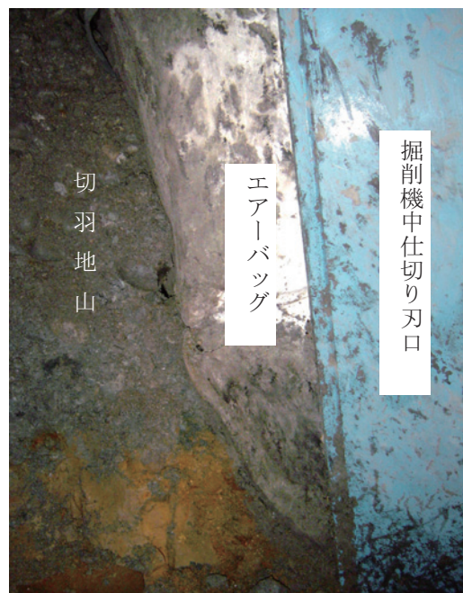
写真-3 エアバッグによる切羽保持状況
