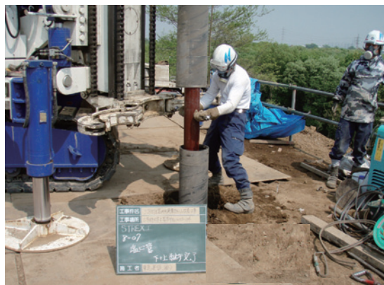
写真-6 施工状況（2）
