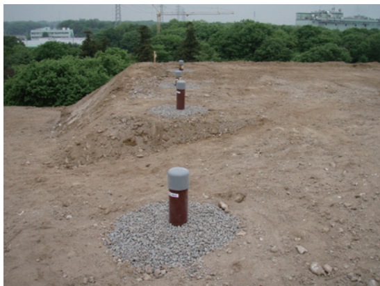
写真-7 井戸設置完了
