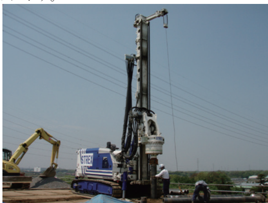
写真-5 施工状況（1）
