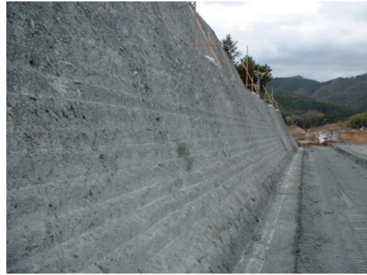
写真-4 掘削後の法面の状況
