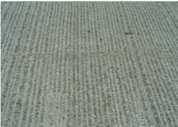
写真-3 掘削面の状況
