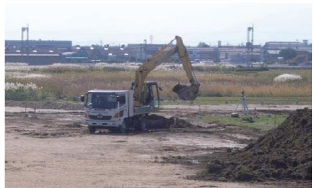
写真-7 3D-MGバックホウによる掘削
