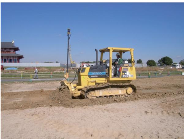
写真-5 3D-MCブルドーザーによる造成
