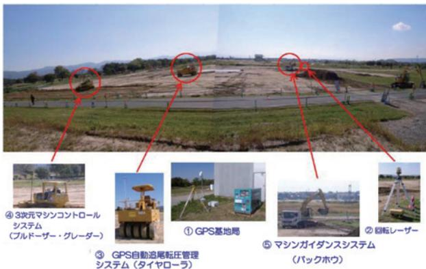
写真-4 情報化施工の全体構成
