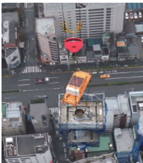
写真-3 柱建方状況
