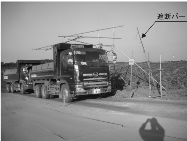
写真-2 シート掛け後、バーを開ける
