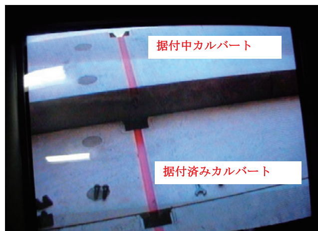
図-11 プレキャストアーチカルバート内部の監視状況
