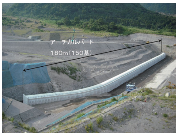
図-20 据付完了全景
