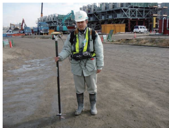
写真-5 工事測量に利用した GPS
