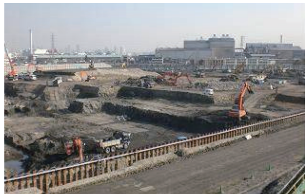
写真-1 掘削状況
