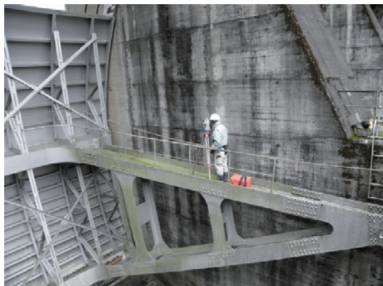
写真-2 ダム堤体の計測状況
