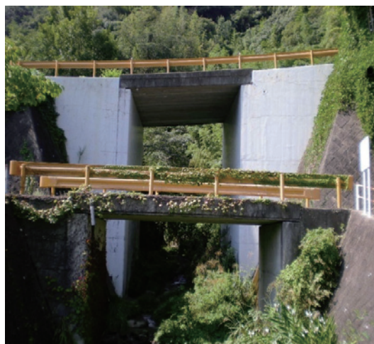
写真-4 調査対象現場
