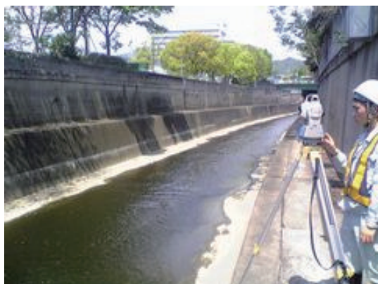
写真-3 擁壁の計測状況
