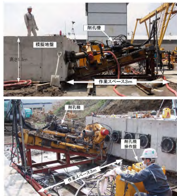
写真-2 削孔作業の状況
