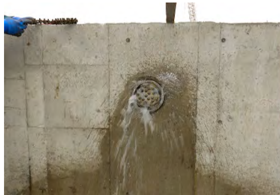
写真-4 鋼管貫通の状況
