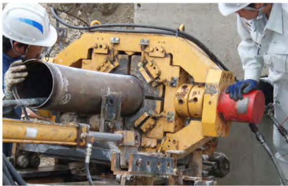
写真-3 圧着による曲線鋼管の接続
