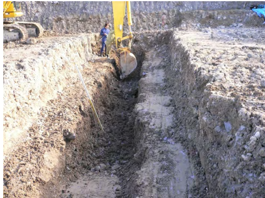
バックホーによる掘削実験の様子
