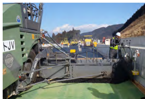
写真－3 施工状況
