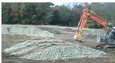
写真-2 複数回実験後の走行障害物
