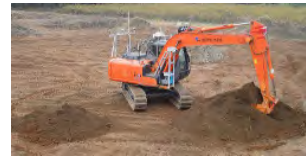
写真-3 掘削盛替実験実施状況
