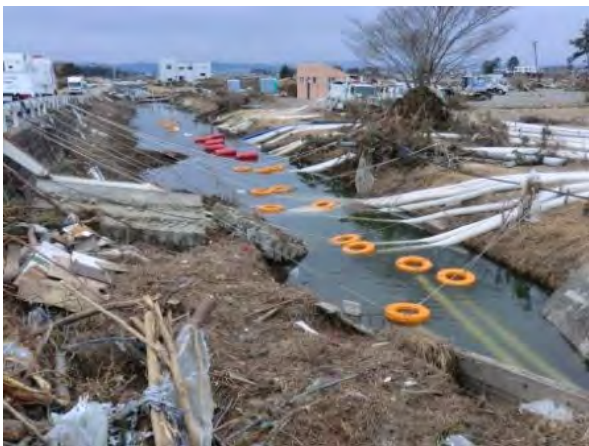
写真-1 排水作業状況（宮城県名取市）
