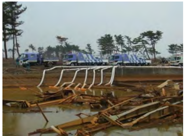
写真-2 排水作業状況（宮城県仙台市若林区）
