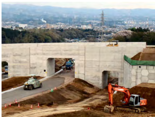
写真 - 5 施工現場（高速道路ジャンクション）
