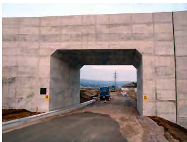
写真 - 7 橋下の施工（○印部分）
