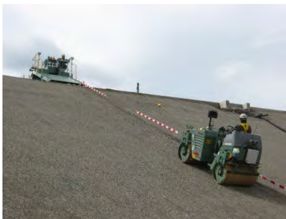
写真 - 4 施工現場（フェーシング工事）
