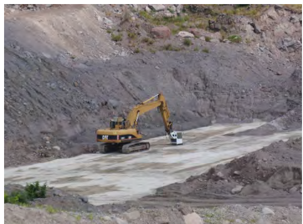
写真-7 施工状況
