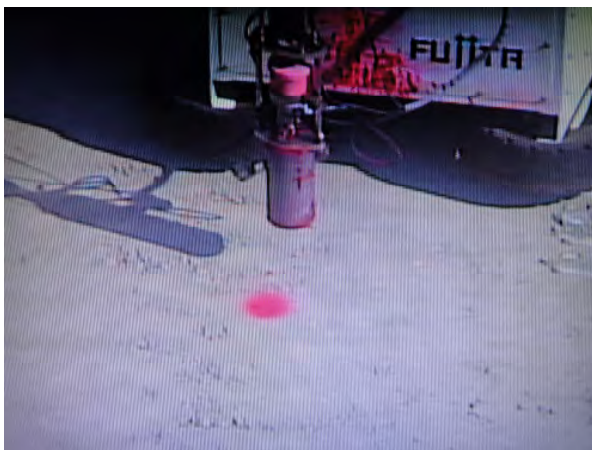
写真-6 マーキング状況
