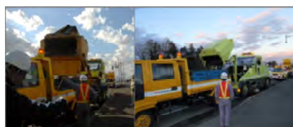
写真-5 積み込み作業の状況（比較）
