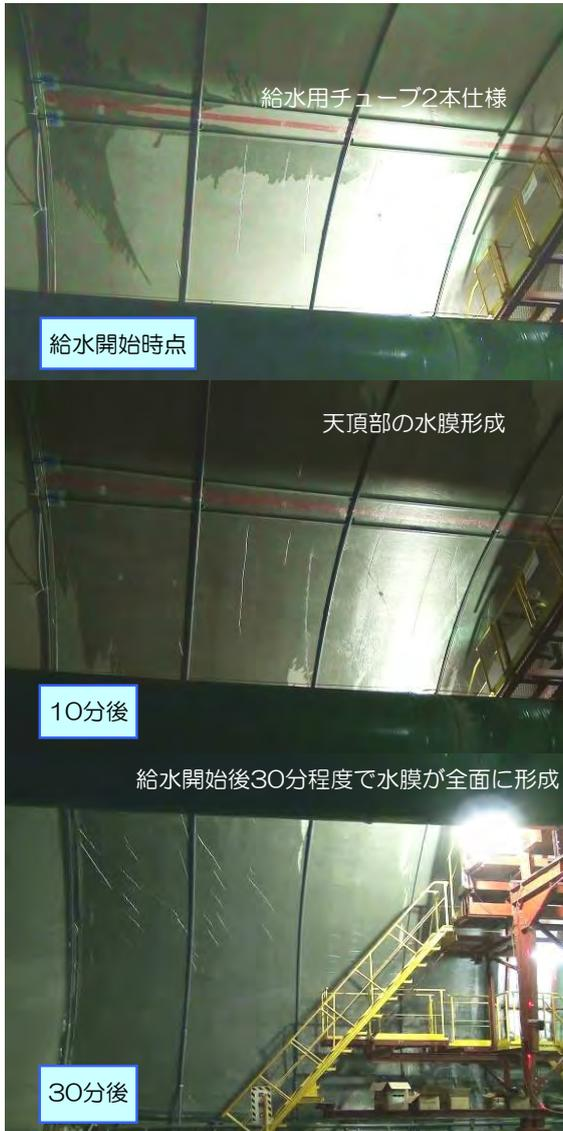
写真-6 トンネルでの水膜形成状況
