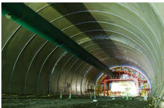
写真-7 浸水養生シート展張完了状況
